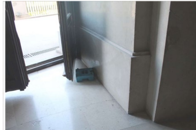
V27. Vista interior de carpintería de acceso a la terraza de Salón de Falla
